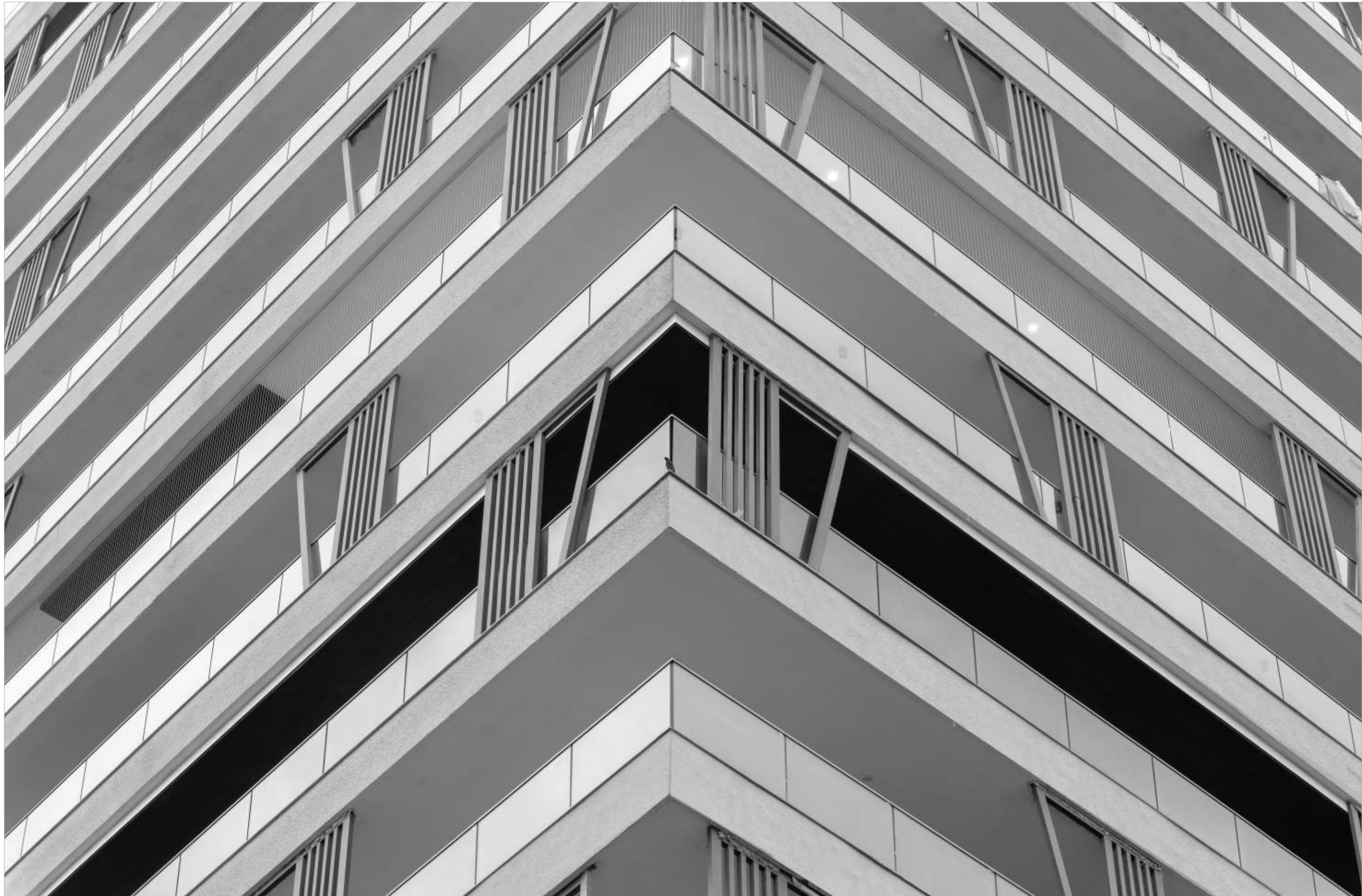
Actual site image
